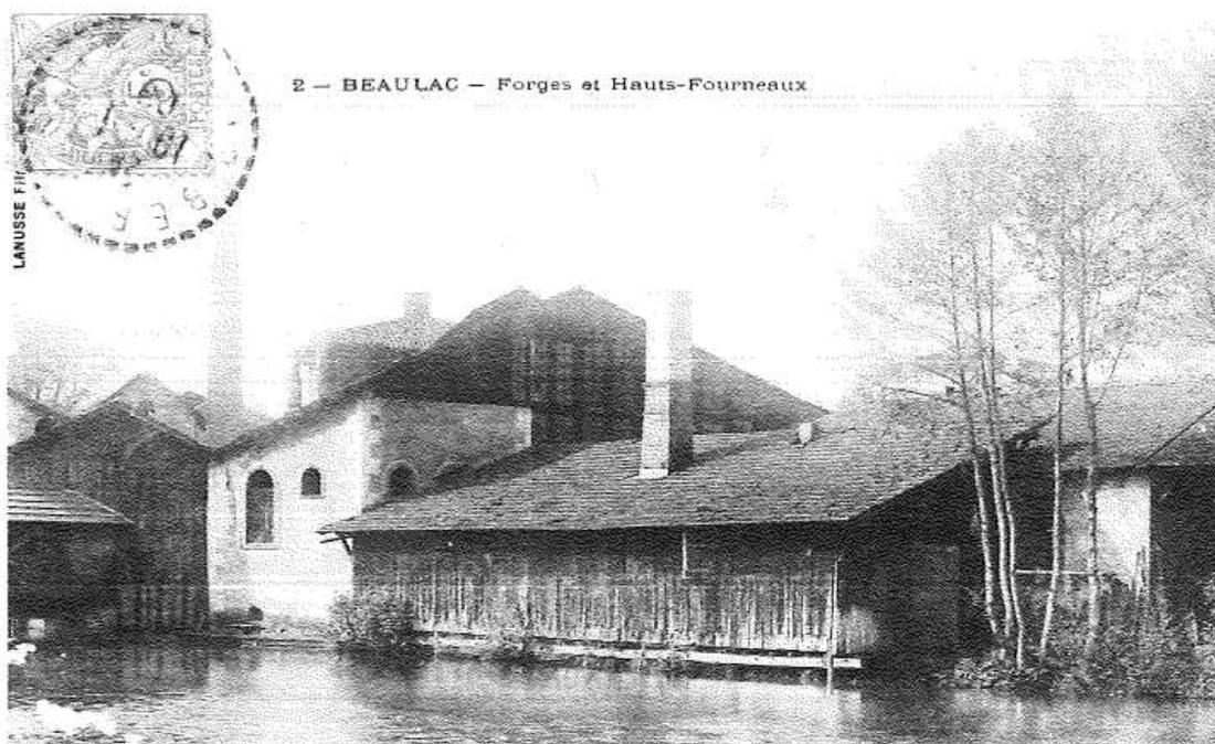
Fig. 6.— La fonderie de Beaulac vers 1900 (carte postale, Lanusse fils, édit.). Les volumes que l'on voit au premier plan sont aujourd'hui remplacés par une construction plus haute. A l'extrême gauche, départ de la passerelle en bois, couverte, par où transitaient les wagonnets de paille.
